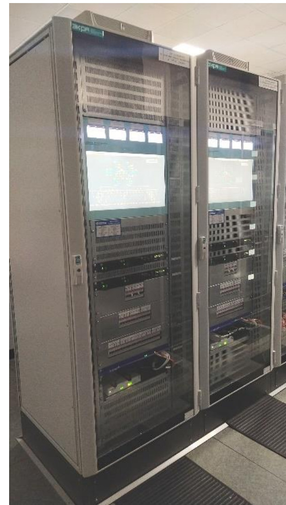
Шкаф основного и резервного ЦИЭУ
